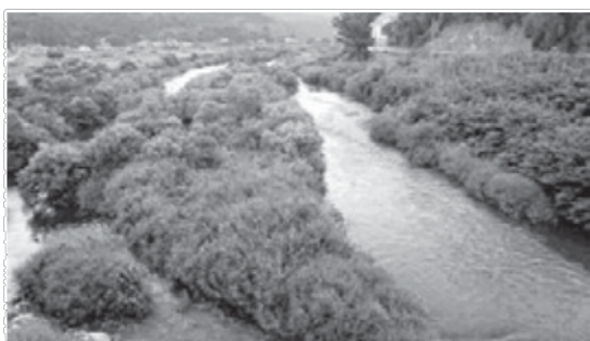
砂鉄川に架かる西前橋付近：早急な河川整備が望まれる
