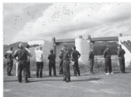
完成した大林水門
