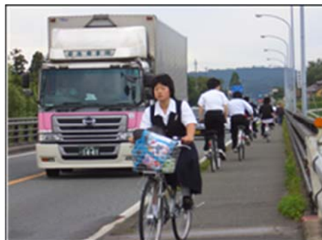
国道 4 号：一関大橋
