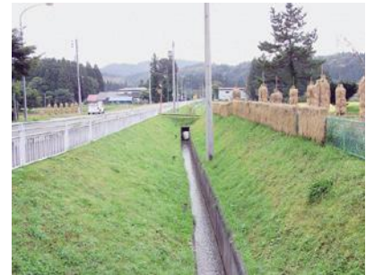
磐井川からの用水路
