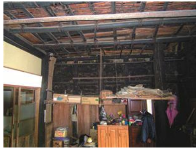
土間に立つウシモチ柱
