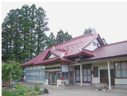
本来茅葺屋根で礎石建・牛持柱を持つ、岩手県南地方における伝統的な農家の特徴を持つ主屋（鉄板葺の赤色の屋根に改変された建物が多い）
