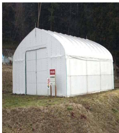
汚染牧草一時保管施設
