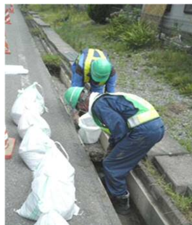
側溝土砂の除去作業 (緊急対応分)
