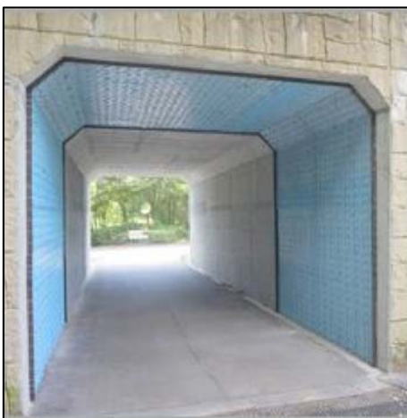
コンクリート補修・補強用格子鋼板筋 (NETIS : QS-150036-A)
