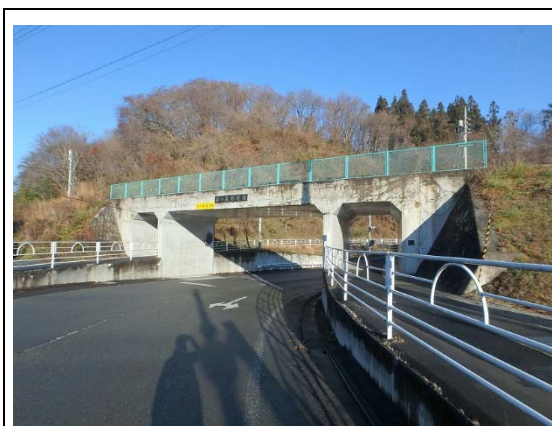
萩の森跨道橋
