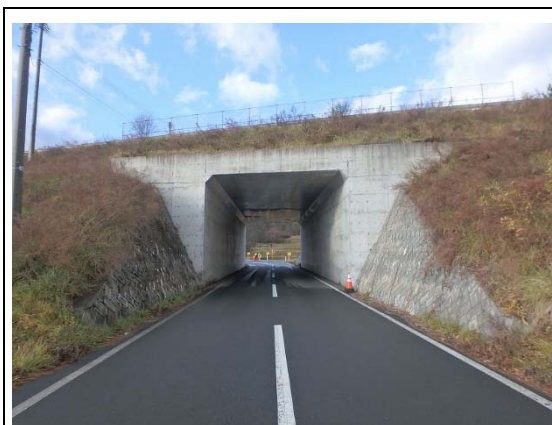
穴ノ沢跨道橋
