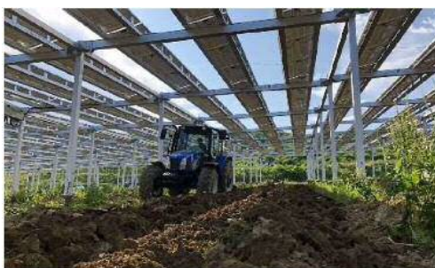
太陽光パネルの下で農地を耕作するトラクター (写真提供:リニューアブル・ジャパン(株)岩手事務所)
