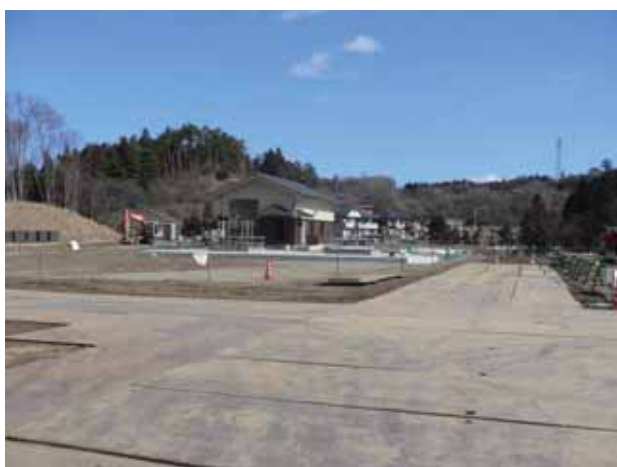
建設中の千厩浄化センター
