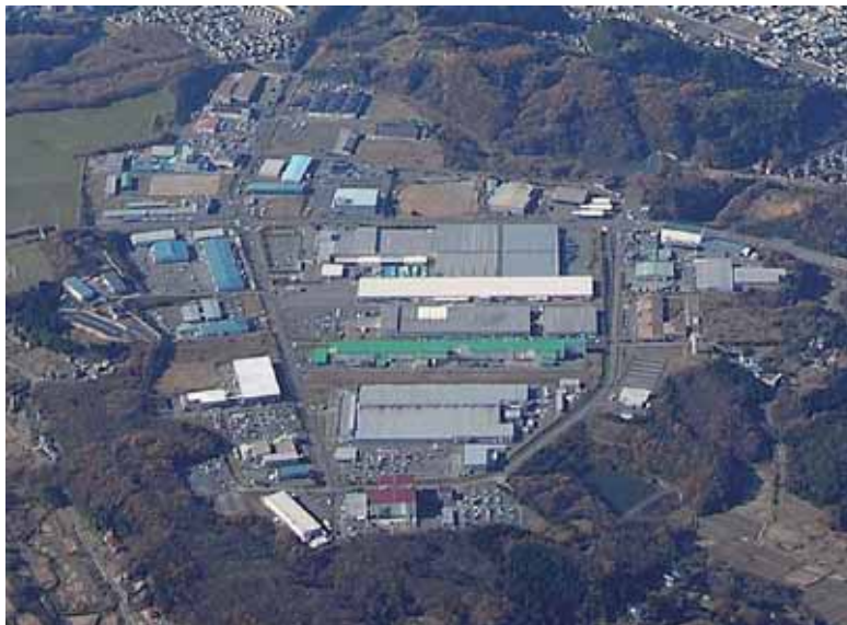
一関東工業団地
