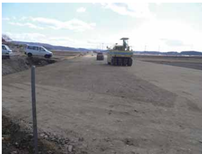
整備中の国道 342 号花泉バイパス
