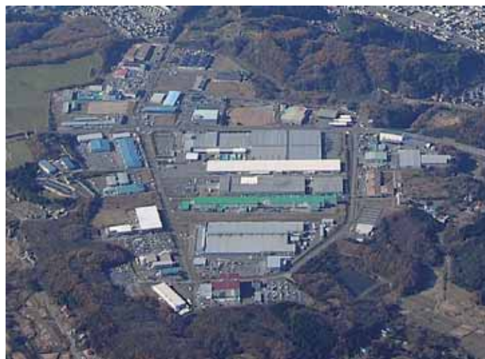
一関東工業団地
