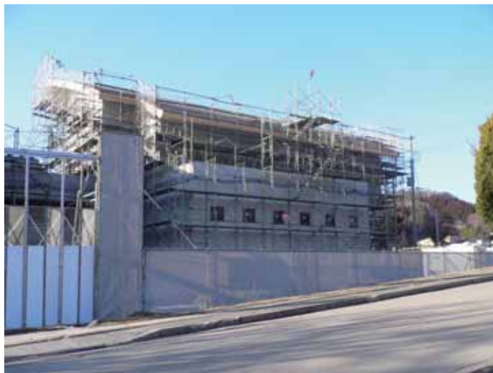
建設中の地域交流センター
