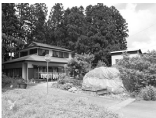
貯水槽施設現況（駒形地区）
