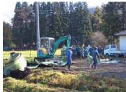
景観を阻害している現在使っていないFRPサイロの撤去作業を行っている様子。
