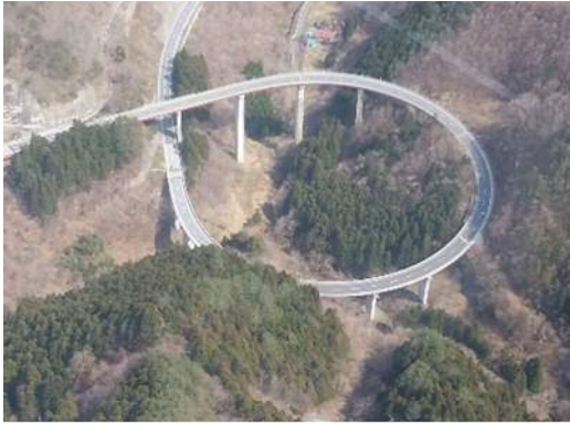
国道 343 号：ループ橋
