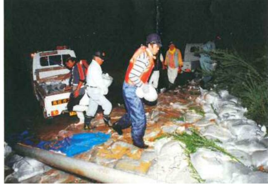
堤防決壊予防のため土嚢積み
