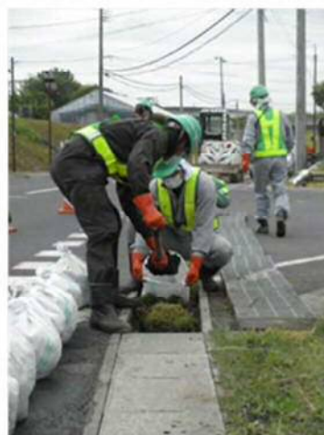
側溝土砂の除去作業
