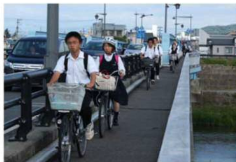
一般県道一関平泉線：磐井橋の歩道
