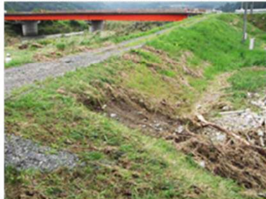
十二木橋下流堤防越水箇所
