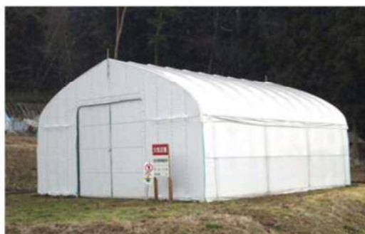
汚染牧草一時保管施設
