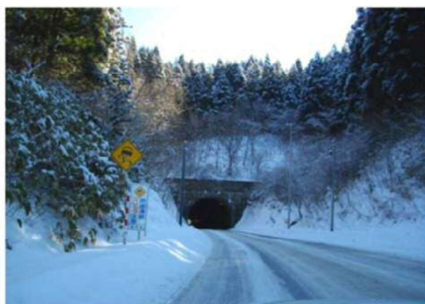
国道 343 号：交通の難所となっている冬の笹ノ田峠
