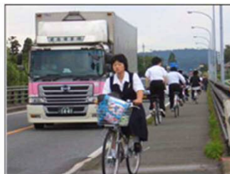
国道 4 号：一関大橋
