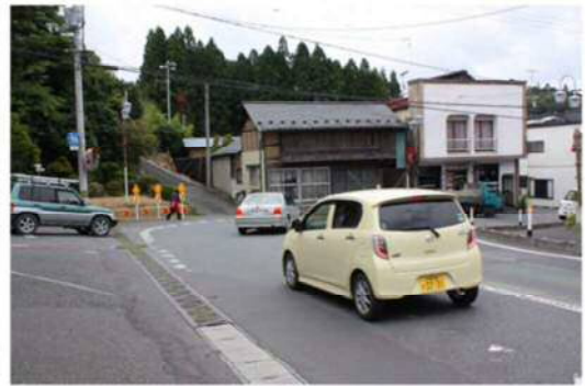
国道 456 号：藤沢小学校付近の急なクランク
